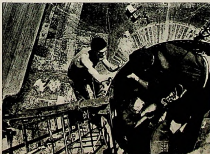
In schwindelnder Höhe zwischen Himmel und Erde. Aus der Tiefe wird ein Blech heraufgezogen, das oben montiert werden muß
